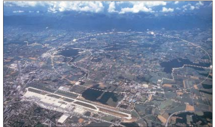
Die Luftbildaufnahme lässt die Ausmaße des neuen Glasfaserdatennetzes des CERN in Genf erahnen (Foto: CERN)
