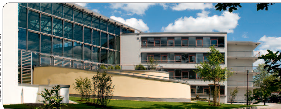
Bild 1: Das Universitätsklinikum Bonn, ausgestattet mit neuer, moderner Datentechnik
