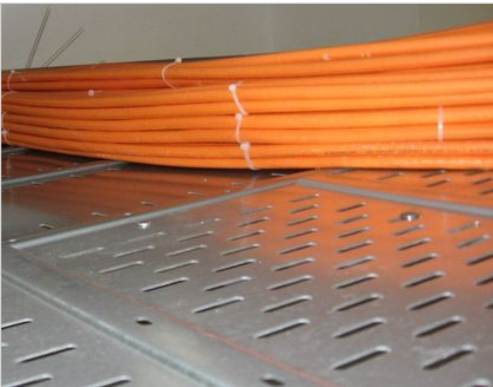
Kabeltrasse entlastet durch tML-Kompaktkabel
