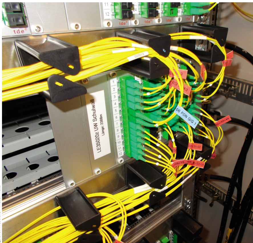
Bild 1: Das tde ODF ist übersichtlich gestaltet und erlaubt es Netzwerktechnikern, die Patchkabel sauber zu verlegen
