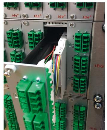
**Mithilfe von Optical Distribution Frames (ODF) lassen sich große Faserzahlen strukturiert und dauerhaft übersichtlich auf geringem Raum terminieren. Steigende FTTH-Anwendungen treiben auch den Bedarf für solche Verteilerschränke**
