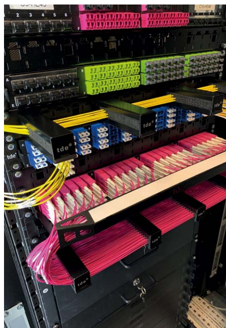
Glasfasern dicht packen: Das tML-LWL-SN-Modul schafft High-Density im Patch-Bereich mit 384 Fasern auf einer Höheneinheit und damit eine Verdoppelung der Packungsdichte gegenüber LC-Duplex-Steckverbindern. Bild: TDE
