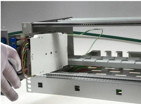
7. Das Spleißmodul an der entsprechenden Stelle einschieben. Dabei ist darauf zu achten, dass die Überlänge der Bündelader sorgfältig im Überlängenfach verstaut wird.
