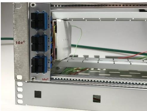
8. Das Einschubmodul wird jetzt an den Baugruppenträger festgeschraubt.
