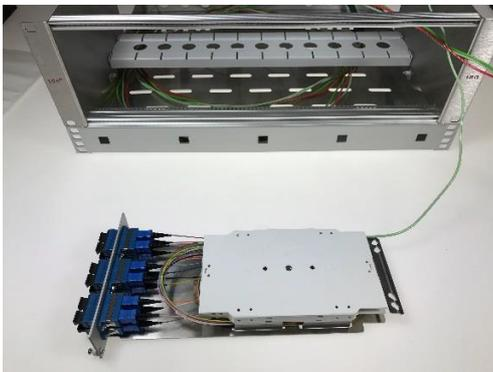
6. Pigtailadern miteinander verspleißen, in Spleißkassette verlegen und diese danach mit dem Deckel verschließen.
