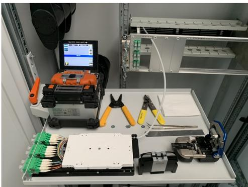
28. Nach dem Spleißen, das Cover der Spleißkassette wieder aufsetzen und den Flexschlauch wie in Schritt 3 in die Aufnahme des tDF® - LWL Spleiß-zu-Patch Moduls führen. Danach das tDF® - LWL Spleiß Modul in die tDF® - Baugruppe einsetzen und mittels der Schrauben befestigen.
