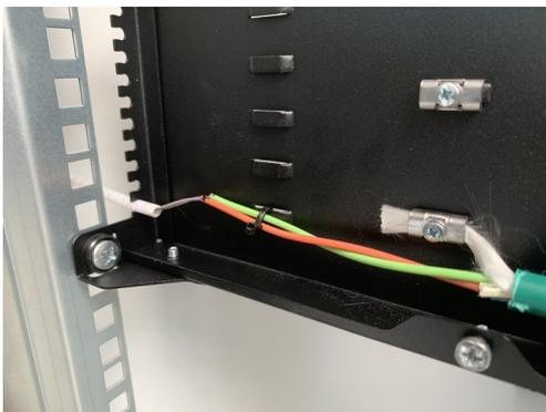
26. Bündeladern mittels Kabelbinder an den Befestigungsstegen befestigen und die tDF® - LWL Kabel Aufteileinheit mit dem vorher abgeschraubten Deckel wieder verschließen.
