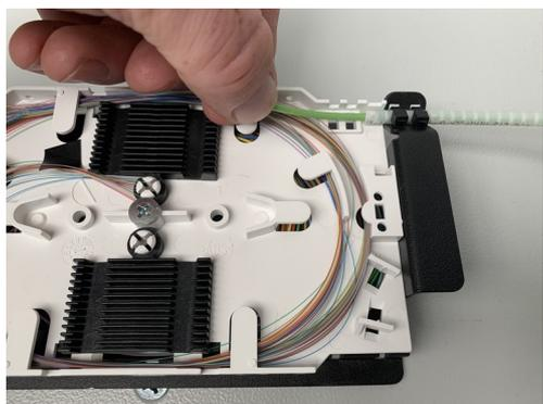
18.... bis diese aus dem Flexschlauch am tDF<sup>®</sup> - LWL Spleiß-zu-Patch Modul kommen. An den Bündeladern vorsichtig ziehen und dabei auf eine saubere Führung der Bündeladern in der tDF<sup>®</sup> - LWL Kabel Aufteileinheit achten.
