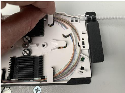
24. Fasern der beiden abgesetzten Bündeladern am tDF@ - LWL Spleiß-zu-Patch Modul herausziehen. Dabei die sichere Führung der Fasern in der tDF@ - LWL Kabel Aufteileinheit gewährleisten.
