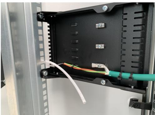
32....und den Flexschlauch in die Aufteileinheit führen.
