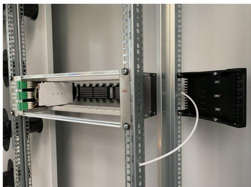
8. tDF<sup>®</sup> - Baugruppe mittels M5 Befestigungsset im tDF<sup>®</sup> - Schranksystem montieren. Ebenso die tDF<sup>®</sup> - LWL Kabel Aufteileinheit an der hinteren abgeschrägten Befestigungsstrebe anschrauben und den Deckel entfernen.
