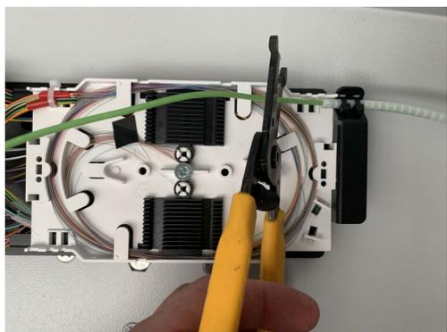
19. Bündeladern mit einem passenden Werkzeug absetzen, Fasern reinigen und mit dem Spleißen beginnen. Spleißen - weiter ab Schritt 25
