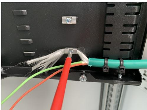
15. Das Stammkabel mittels Kabelbinder an der tDF® - LWL Kabel Aufteileinheit befestigen. Die Zugentlastungselemente des abgesetzten Kabels je nach Bedarf ausdünnen und ebenfalls befestigen.
