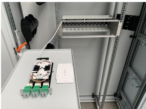
13. Das tDF® - LWL Spleiß-zu-Patch Modul aus dem tDF® - Baugruppe entnehmen, den Deckel entfernen und mit grade verlegtem Flexschlauch vor dem Baugruppenträger platzieren.
