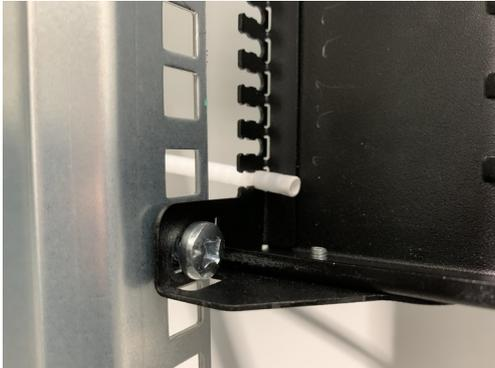
9. Flexschlauch wie abgebildet an passender Stelle in die Führung der tDF<sup>®</sup> - LWL Kabel Aufteileinheit drücken und abschneiden (dabei sollten min. zwei Glieder des Flexschlauchs stehen bleiben). Somit ist die korrekte Länge der Flexschläuche gewährleistet.
